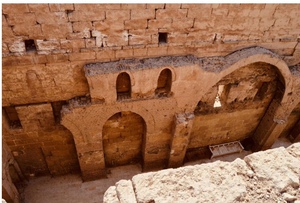
Различни строителни фази на защитната стена на Белия манастир, Сохаг.
